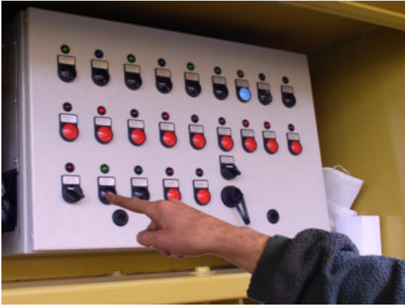
1:- Press button "Clamp On".
